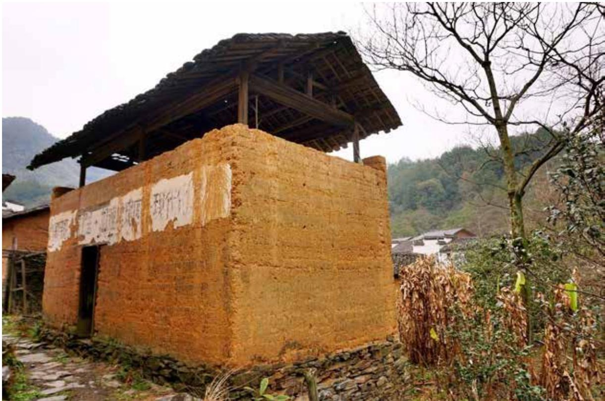
两侧像搓板一样不平，还得用铁锹铲平，最终，铲下的多余的土还得运走，多费了许多气力……修整新墙，也正如荣爹所说，要铲墙、运土，考究的人家，还要在墙的外侧加上稻草编织的簾子，草簾子一层层依次错开，上方用和好的泥涂抹固定，土墙穿上这样的“稻草裙子”，更能抵挡雨水的侵蚀。土墙到屋檐还有一段空隙，就用柴扉挡住，柴扉也抹上泥土，这样，新的土墙就全部竣工了。
